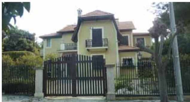
Κατοικία του Κ. Αγαπτού στην οδό Δάφνης
